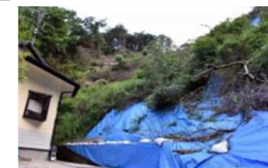
豪雨の度に土砂崩れが多発
